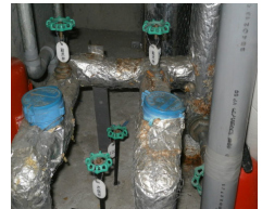
(パイプシャフト内) 水抜きバルブを閉めて、給水バルブを開いて下さい
